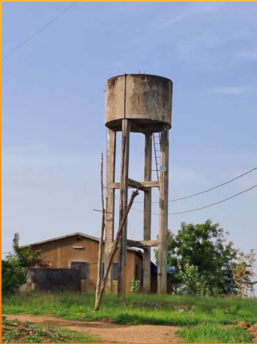
Le château d'eau du site
