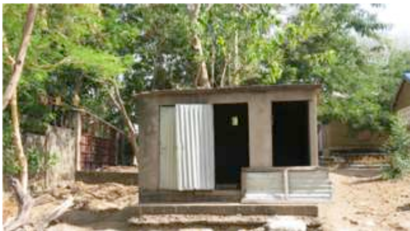
État des toilettes avant travaux
