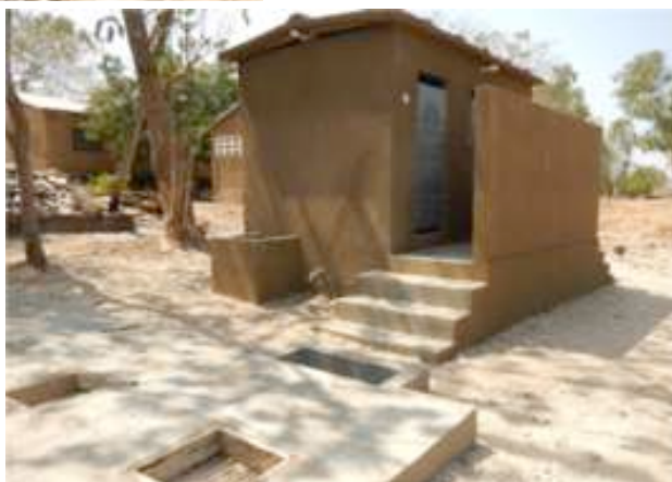
Toilettes après rénovation
